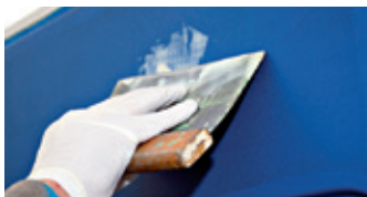
Fill using blade
